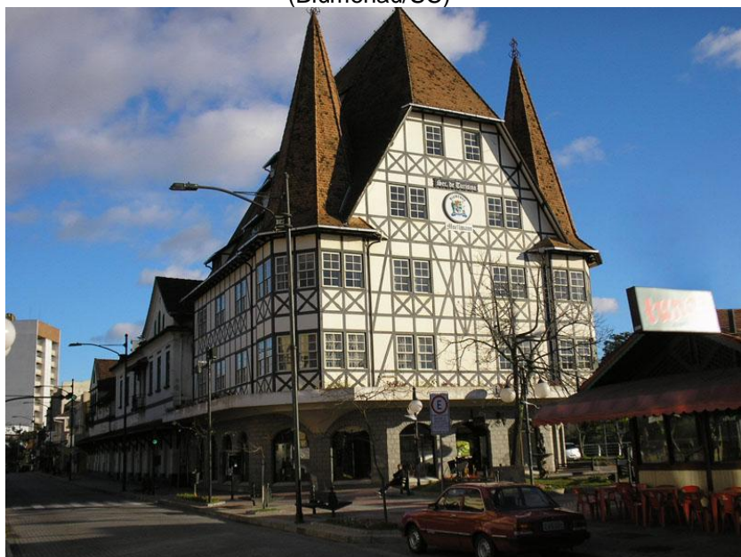
Figura 9: Rua XV de Novembro – Fachada Castelinho Moellmann (Blumenau/SC)
