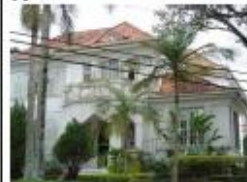
Rua Marechal Floriano Peivoto, 536 / Bom Retiro
