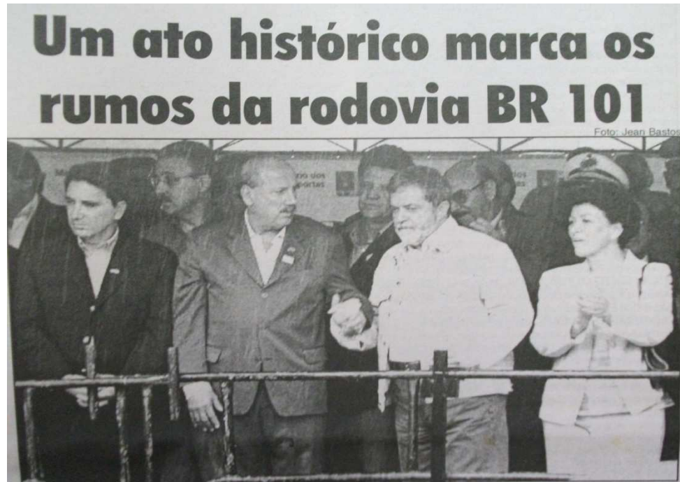
Figura 19: Capa do jornal com manchete sobre o início das obras de duplicação.
