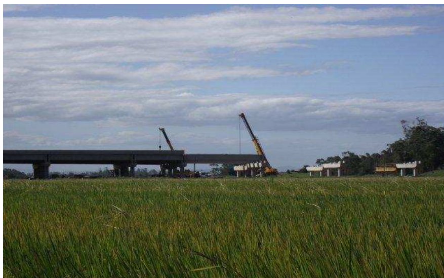
Figura 26: Construção dos elevados do desvio em Araranguá, rodovia BR-101. Fonte: www.engeplus.com.br .
