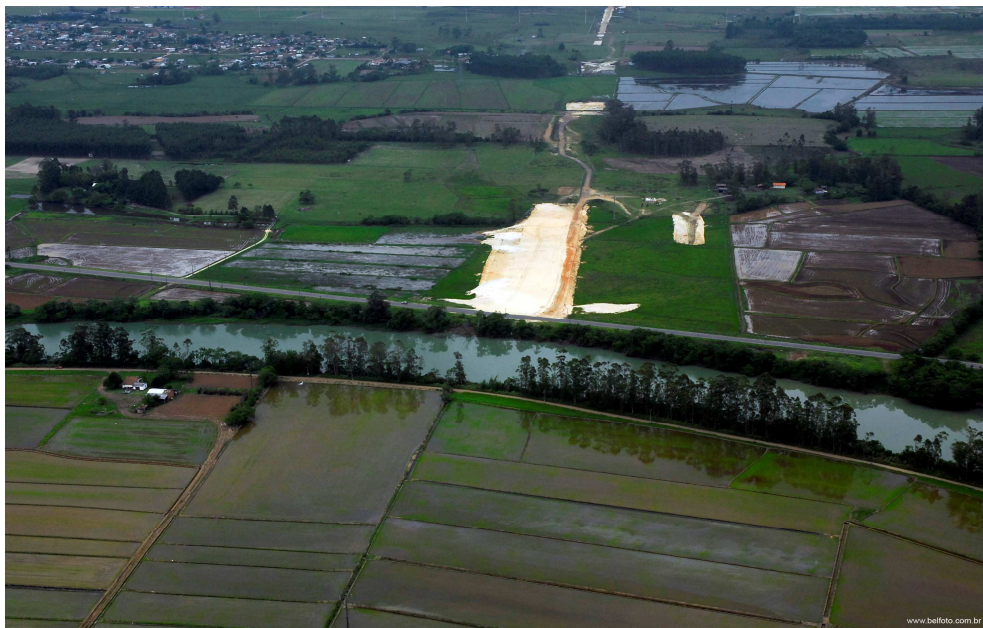
Figura 25: Construção trecho do contorno de Araranguá da rodovia BR-101.
