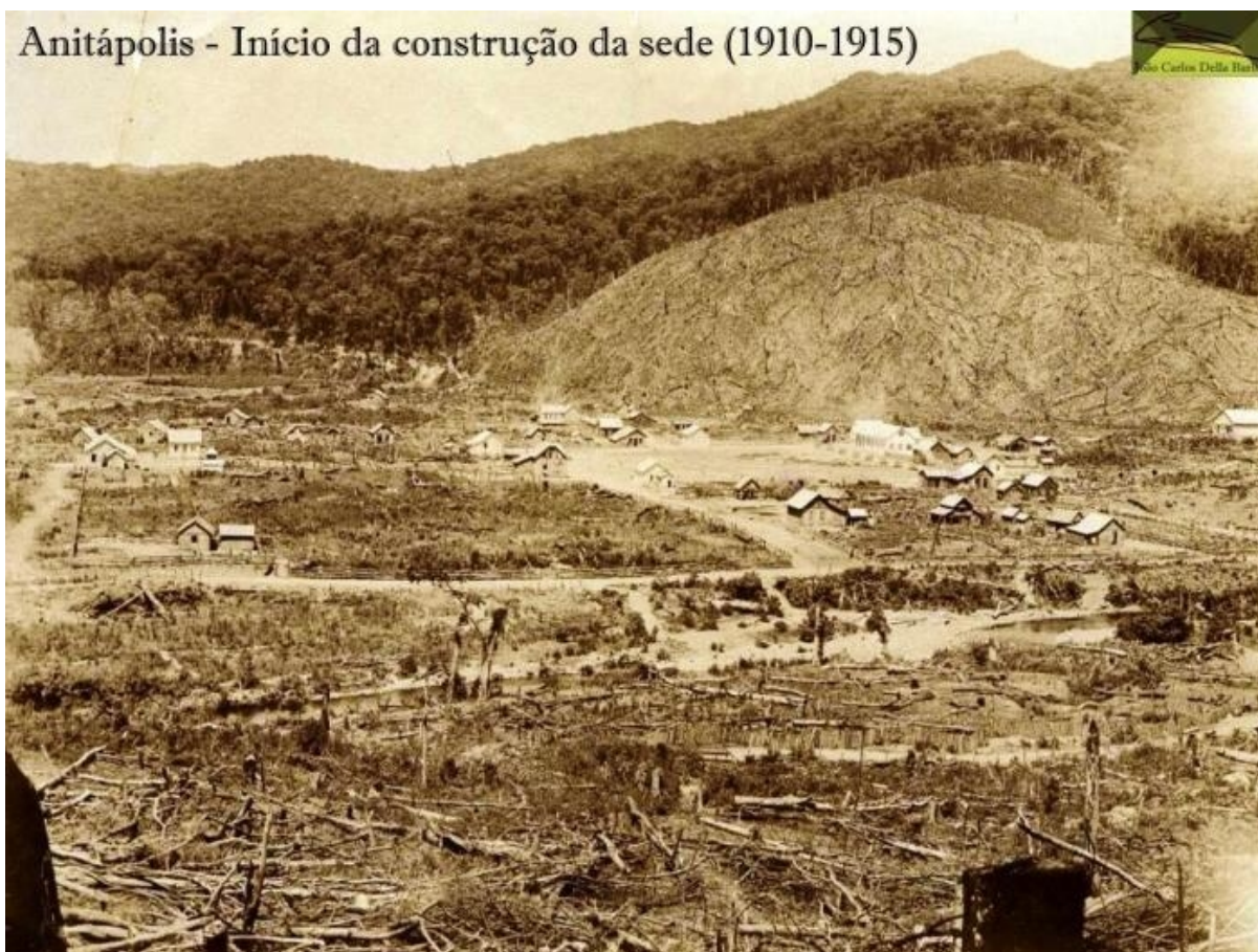
Figura 6 – Início da construção da sede do Núcleo Colonial Anitápolis – 1910 - 1915 22
